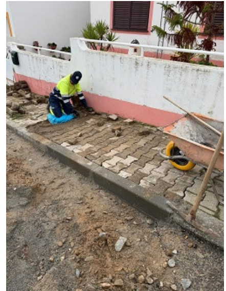
Reparação de passeio na zona J.
