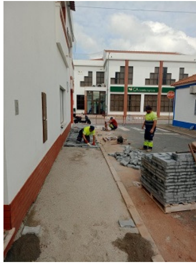
Substituição de troço de passeio na Rua Dr Graziela Pascoa Fernandes;
