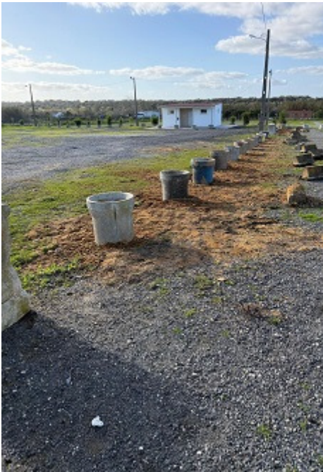
Colocação de manilhas/floreiras para organização do espaço de mercados e feiras;
