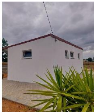
Instalações sanitárias (Mercado)
