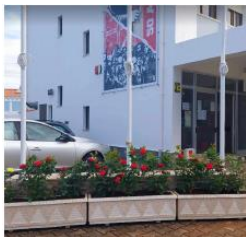
Colocação de Mastros e canteiros
