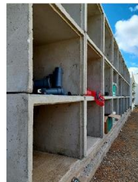
Construção de 30 novos gavetões
