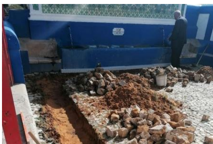
Intervenção na Fonte da Bica
