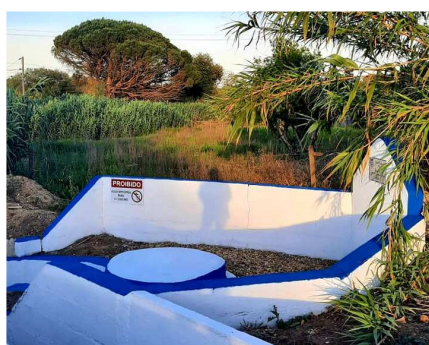
Fonte da estação, conservação
