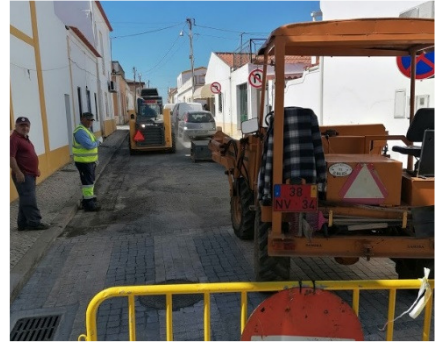
Aplicação de betuminoso
