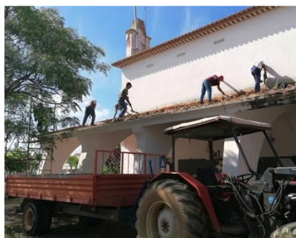
Obras de remodelação
