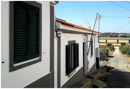
Pintura e reparação do Posto da GNR de Alvalade
