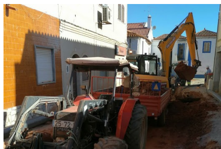
Obras no centro histórico - apoio com meios
