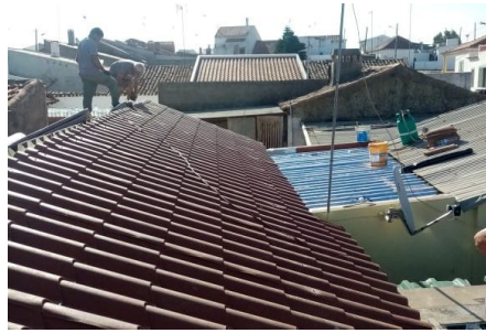
Reparação do telhado da casa de função do coeiro
